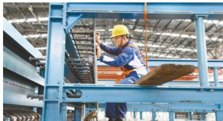
永祥树脂员工在节日期间清除装置铜排接触条原导电膏,并用砂布抛光,为重新组装离子膜做好准备
