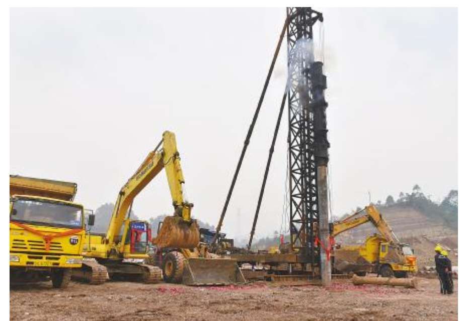
永祥新能源高纯晶硅二期项目打下第一根桩
