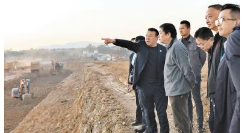
保山市委书记赵德光多次莅临云南通威高纯晶硅项目建设现场调研
