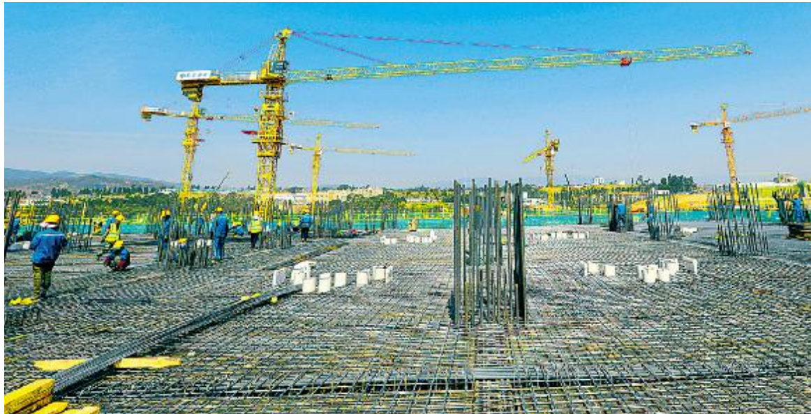
项目建设现场
