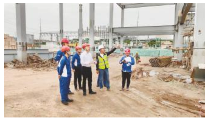
永祥光伏科技召开项目现场进度督察会
