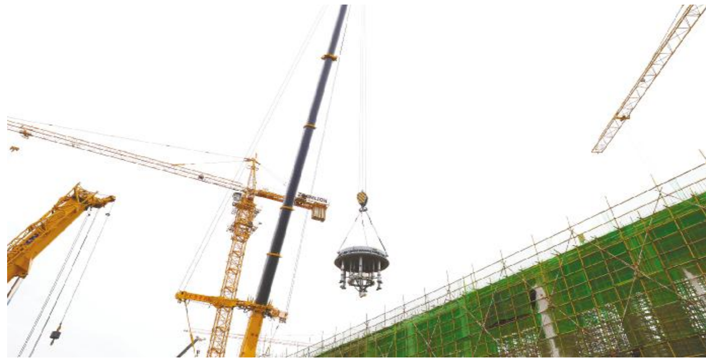
内蒙古通威高纯晶硅公司二期还原炉吊装现场
