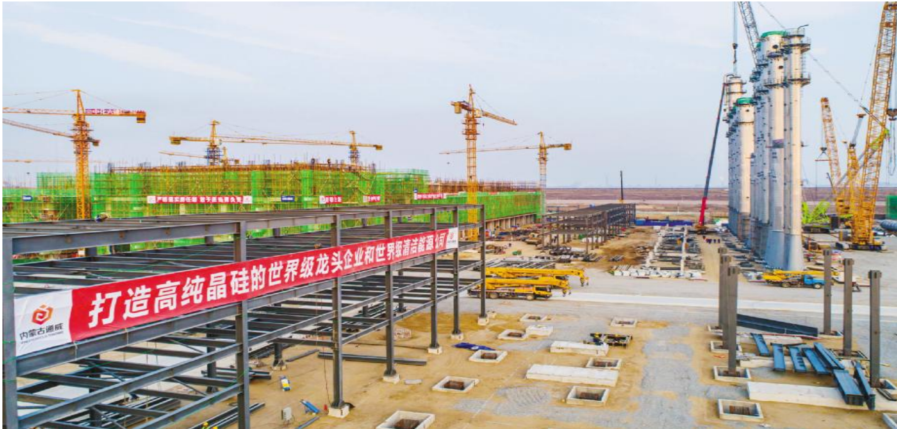
内蒙古通威建设现场
