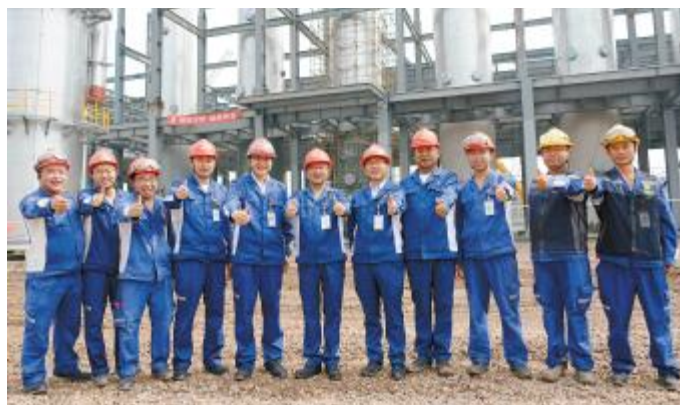
2021年6月28日,永祥新能源精馏塔最后一吊完成
