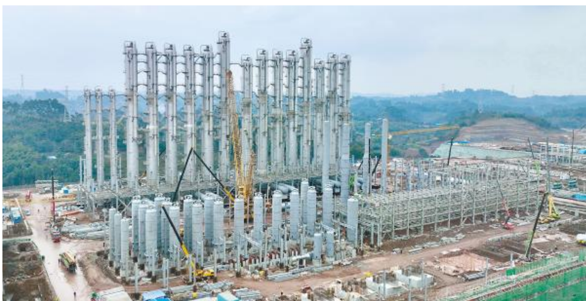
永祥能源科技一期项目建设热火朝天
